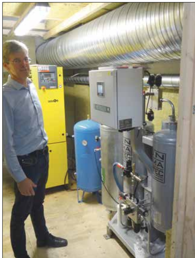
Nitrogen ud af den blå (atmosfæriske) luft: Ravi bruger ikke så meget N 2 i deres selektive lodder, så frem for at bruge tanke med et vist tab er det en bedre løsning at "producere" nitrogen selv, når lodderen kører.
